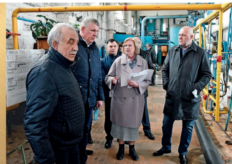
Осмотр объектов теплоснабжения, Конаковский муниципальный округ, 2021 г.
